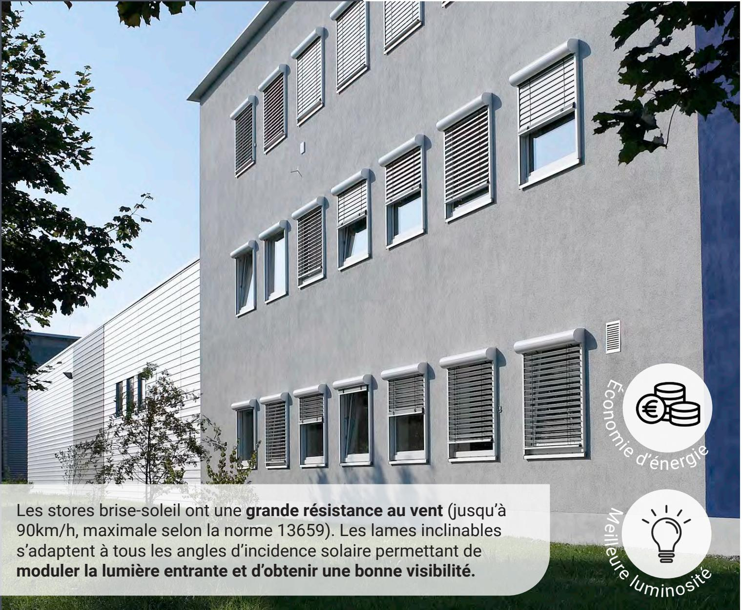
Les stores brise-soleil ont une **grande résistance au vent** (jusqu'à 90km/h, maximale selon la norme 13659). Les lames inclinables s'adaptent à tous les angles d'incidence solaire permettant de **moduler la lumière entrante et d'obtenir une bonne visibilité**.
